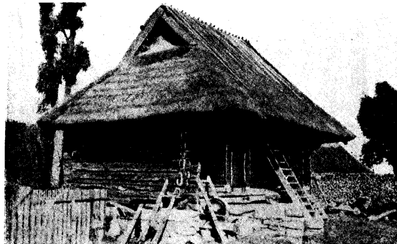
Joon. 21. Kõrge kivialusega ait Kihelkonnal Saaremaal.
